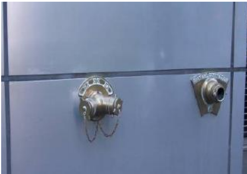
259. ábra Külső fali csatlakozó
