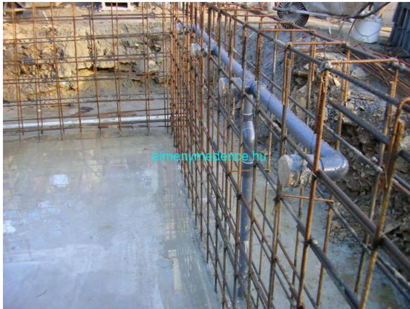
242. ábra Vasszerelés között vezetett PVC medencevíz cső
