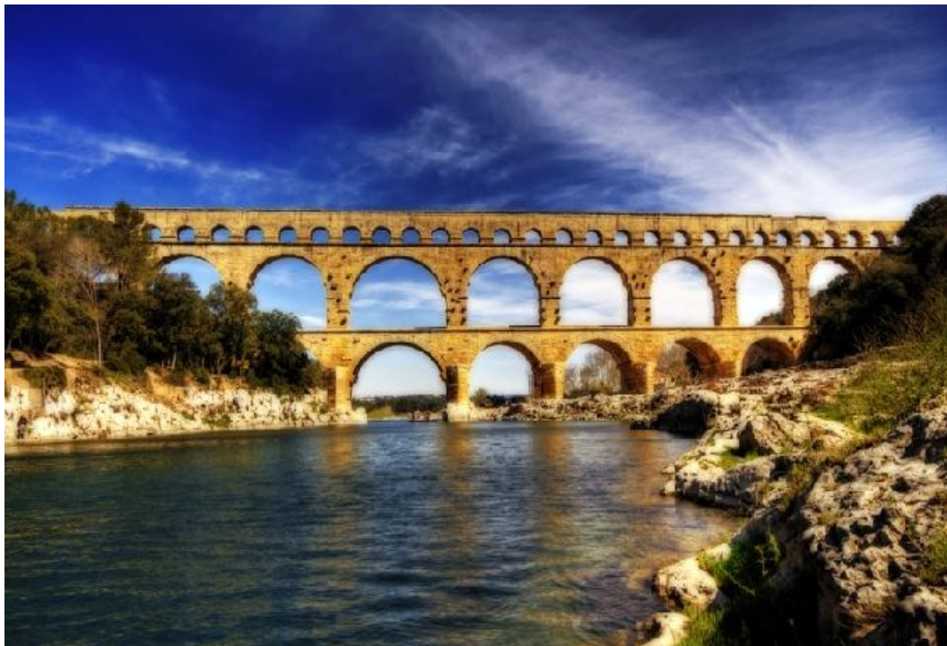
2. ábra Falazott vízvezeték folyó felett vezetve
