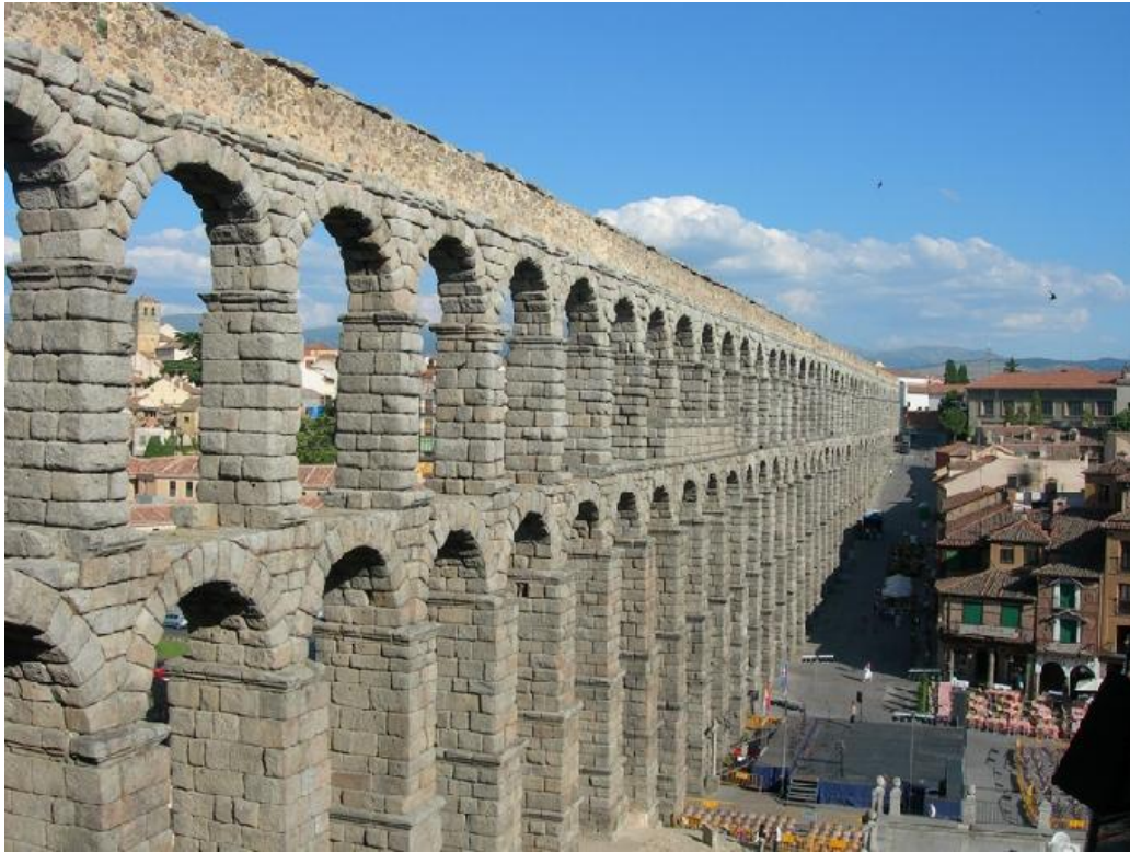
1. ábra Falazott vízvezeték magasan vezetve
