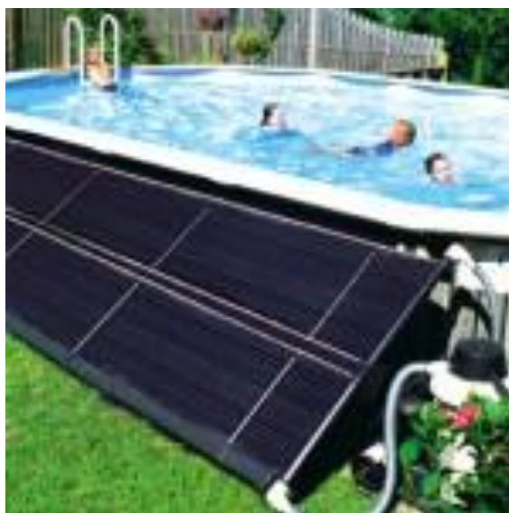
247. ábra Medencefűtés abszorberes napkollektorral
