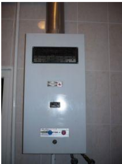
180. ábra Kéményes átfolyó üzemű vízmelegítő 12 l/perc
